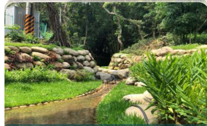
■ 山溝以生態砌石工法作為生物廊道
