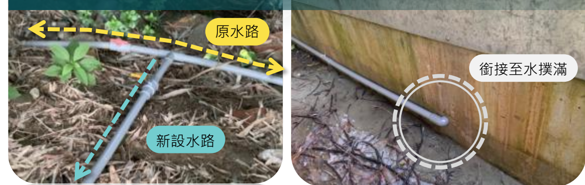
由水源地接管至水撲滿，讓涓涓流水滋養水梯田
