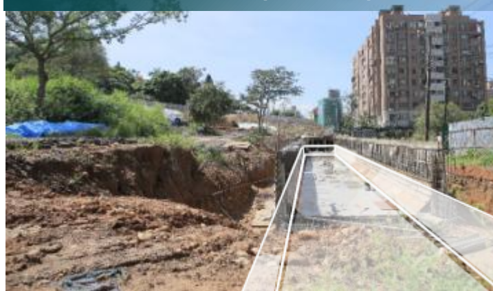
滯洪沉砂池照片(施工中)
