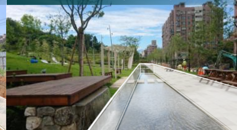
滯洪沉砂池照片(完工後)
