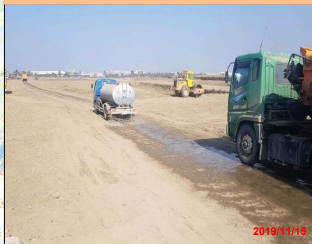
工區加強灑水
