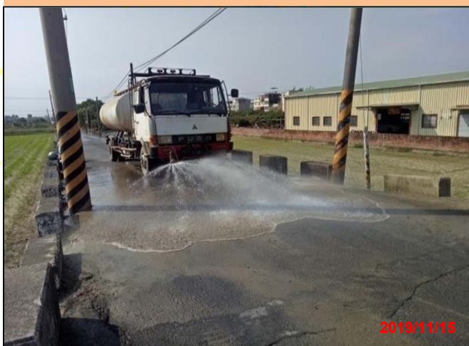
工區外道路清洗作業
