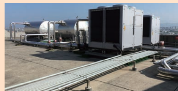
男女二舍淋浴用熱水新設熱泵系統
