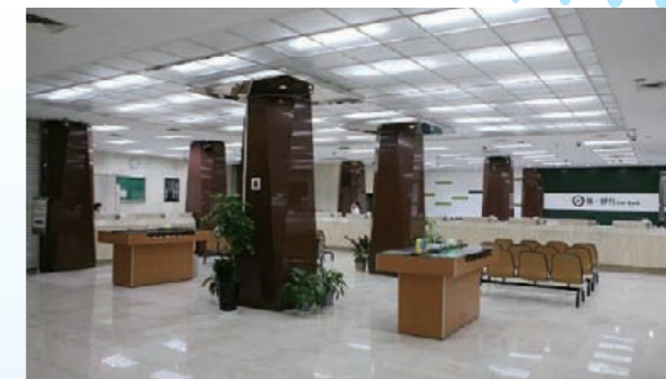
大樓室內外照明導入 LED 節能燈具及控制手法
