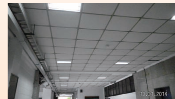
傳統 T8 燈具逐年更換為 T5 燈具及 LED 燈
