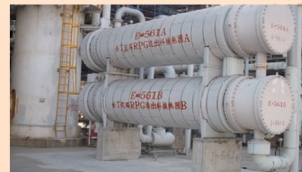
增設換熱器 E-561 · 加熱汽油氫化單元進料
