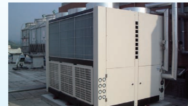
宿舍採用熱泵節能系統
