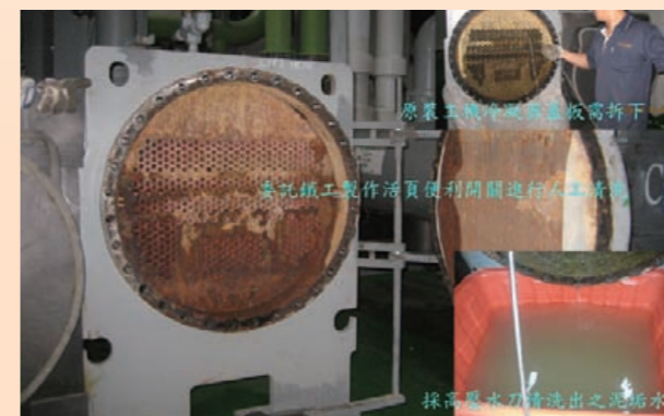
冷凝器採水刀清洗
