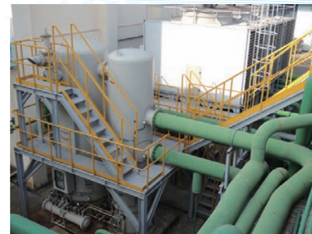
電能節能改善 - 採用墨田式乾燥機取代冷凍式乾燥機
