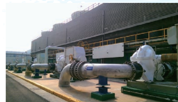
冷卻水塔泵浦內部 Coating 節電改善
