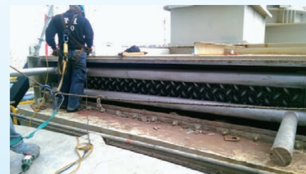
加熱爐新增爐管 (節熱器)
