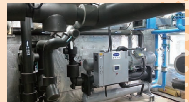
滿液式高效率空調主機更換
