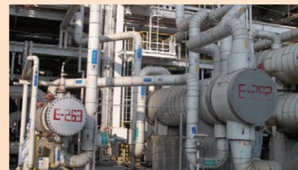
增設換熱器回收製程低階餘熱
