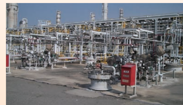
混合四碳進料泵浦操作模式修改
