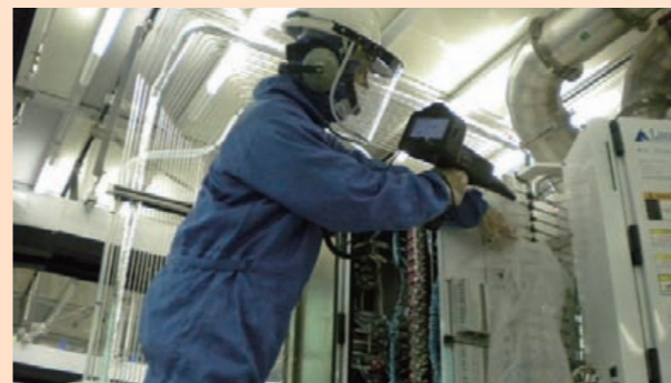
使用超音波儀器檢查生產機台洩漏
