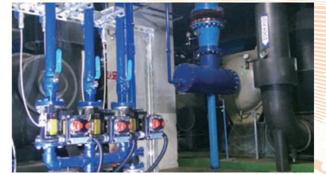
冰機冷凝器自動清洗機
