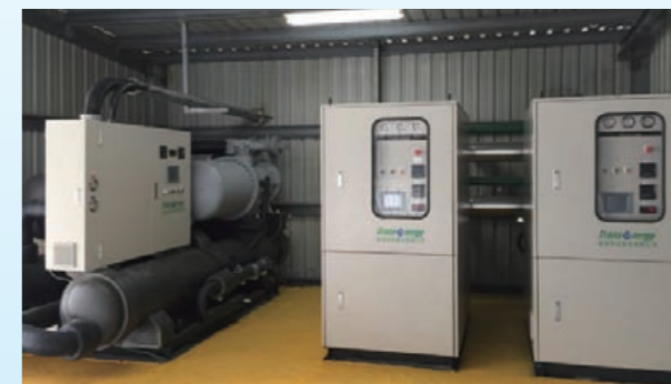
增設高溫熱泵取代蒸氣製造熱水
