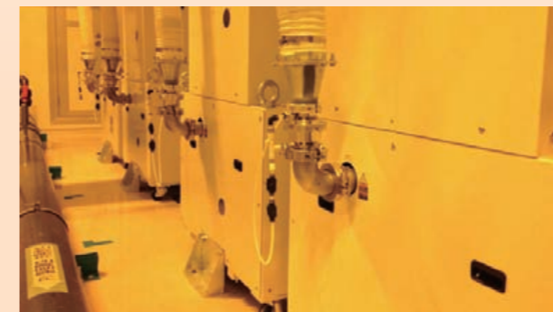
自主研發設置 Dry pump 真空節能器
