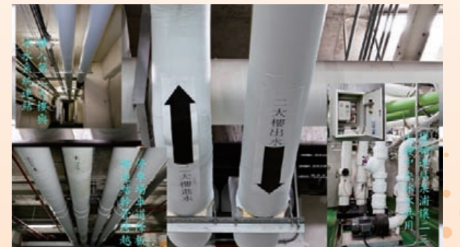
第二三大樓中央空調冰水連結工程
