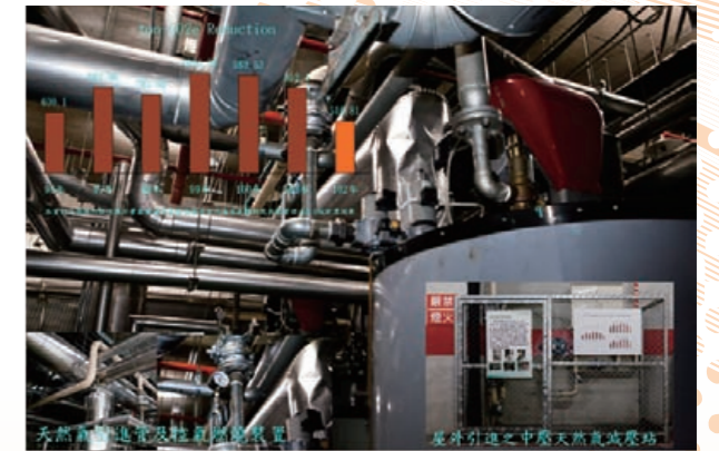
鍋爐由柴油改採天然氣工程
