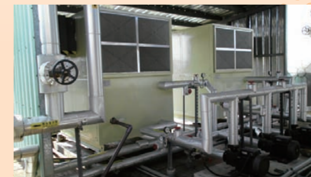
學生宿舍裝熱泵熱水系統
