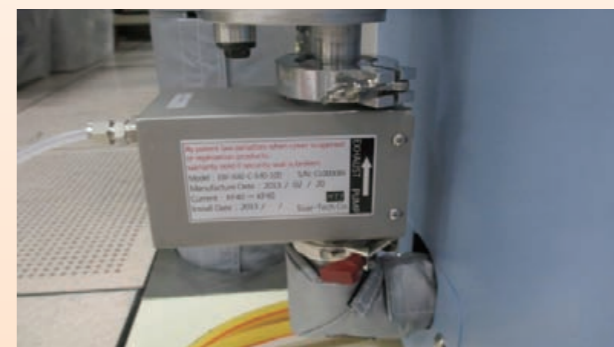
安裝 PSU 裝置，減少 Dry Pump 壓降
