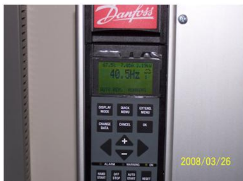
地下二樓~地下五樓公共進排風採中央定時變頻控制10台
