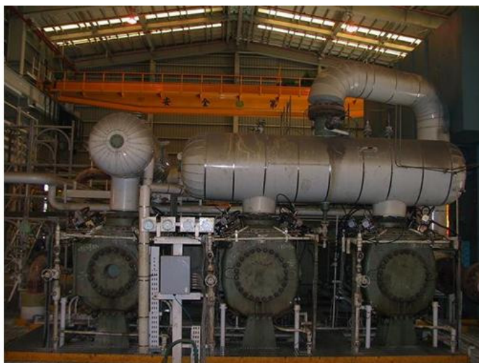
壓縮機無段式升降載節能系統之外觀。
