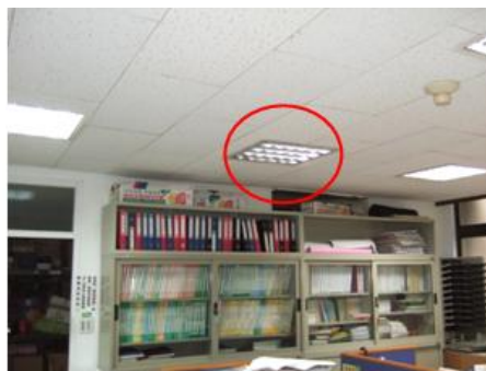
辦公室照明拔掉部份燈管改善後狀況
