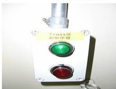
1)FAB-1 truss area照明開關關閉前
