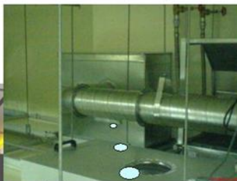
熱排氣導入RCU回潔淨室措施照片
