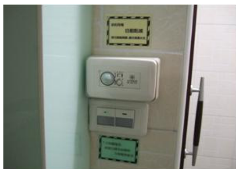
廁所照明設備加裝紅外線感應器
