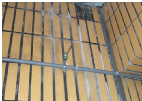
配電大樓空調系統溫度感應棒
