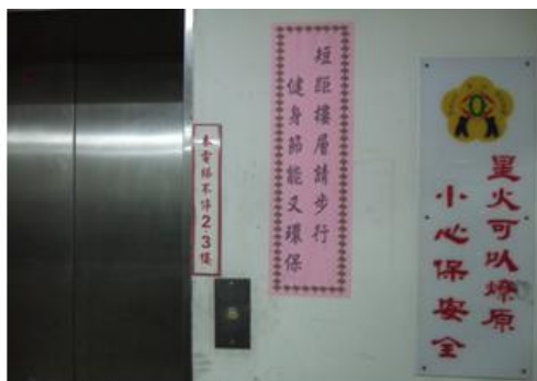
電梯實施分層流量管制及粘貼宣導標語
