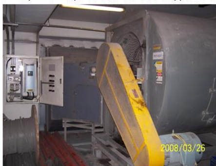
地下二樓~地下五樓公共進排風採中央定時變頻控制10台
