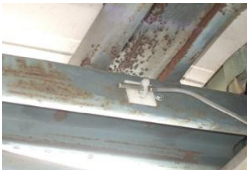
南、北棟大樓空調系統溫度感應棒
