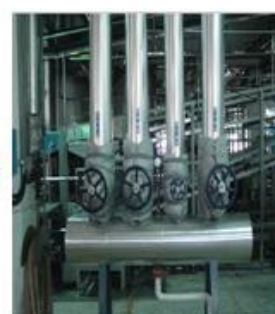
蒸汽混合缸
