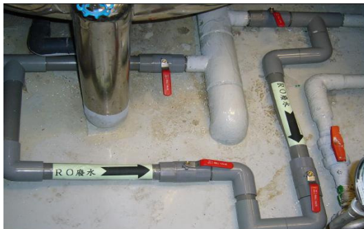
洗腎室RO廢水管路修改
