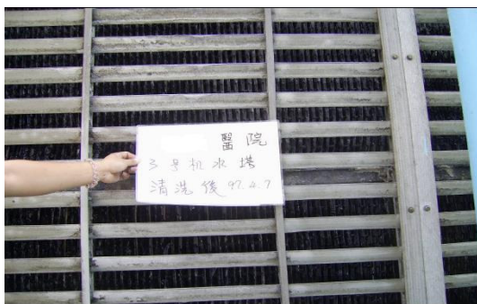
冷卻水塔清洗後
