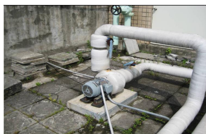
頂樓加裝中繼泵
