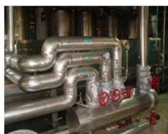
主蒸汽和回收蒸汽混合後進入蒸箱
