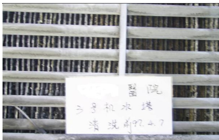
冷卻水塔清洗前
