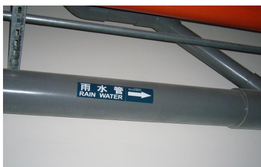
8英寸雨水回收幹管
