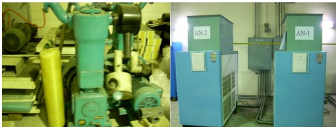
汰舊換新醫用氣體空壓機系統
