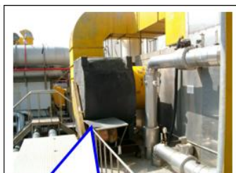
MOTOR PULLEY 改小 250mm→
