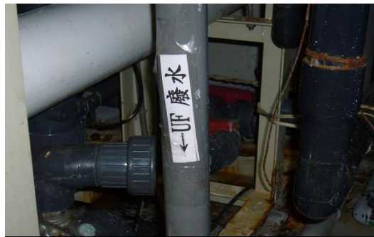
洗腎室UF廢水管路修改
