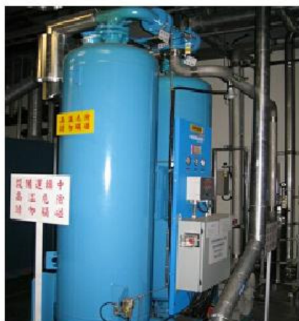
增加熱式乾燥機 HBP-1300 Dryer#8
