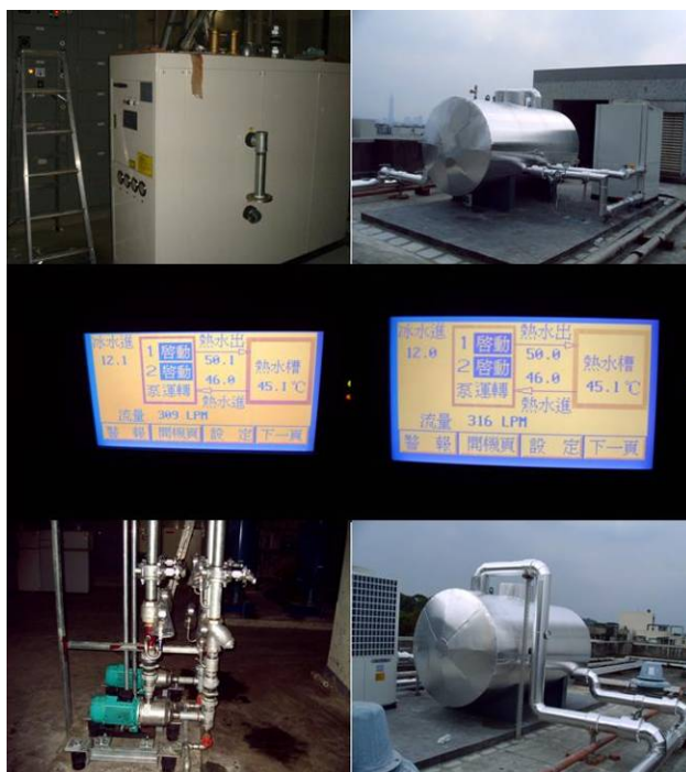
水對水型式及空氣對水型式之熱泵機系統
