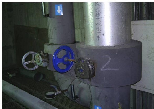
雙冰水空調系統經由閥體的切換運用可串聯及並聯相互支援調配
