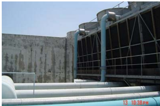
冷卻水塔的冷水盤部份均設有共通管路，用以增加散熱面積
