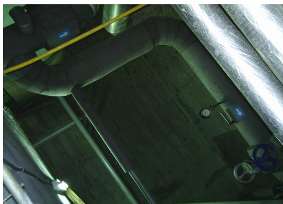
將雙冰水系統利用管路加以串聯使得空調冰水系統更能靈活運用
