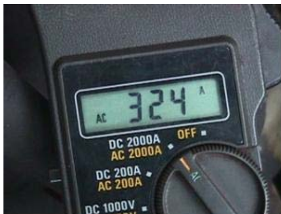
舊型空壓機運轉電流
