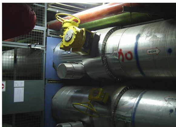
加裝30"閥體方便日後操作維修避免水資源的浪費
