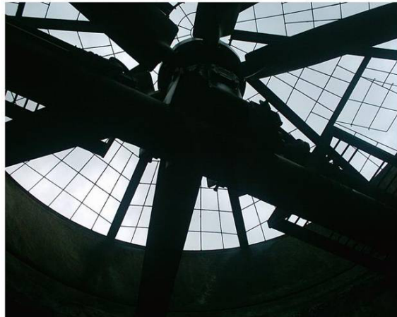
調整冷卻水塔CT1~CT5散熱風扇扇葉角度以發揮其最大功效
