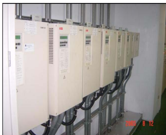
排氣風車以變頻器控制輸出
