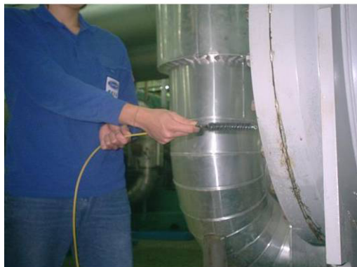
以自製毛刷加強冷凝器清洗
