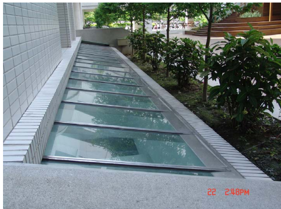
地下室自然通風採光
