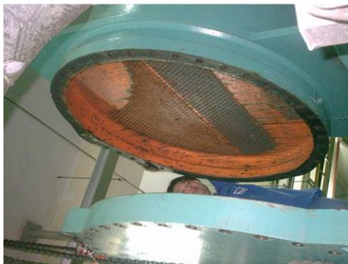
右半部為未清洗的狀況左半部為利用高壓水柱清洗後的情況
