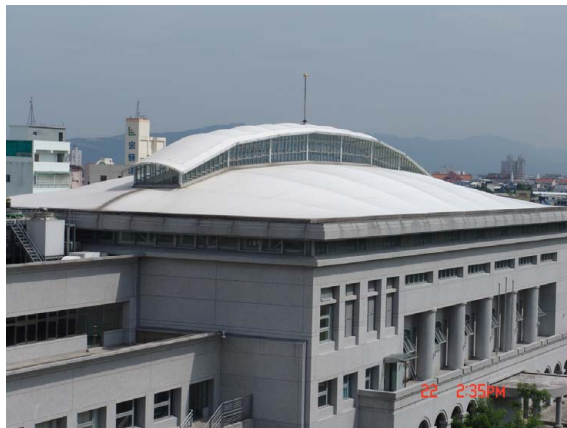
體育館薄膜屋頂
