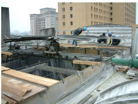
冷卻水塔CT2~CT4塔體整修
