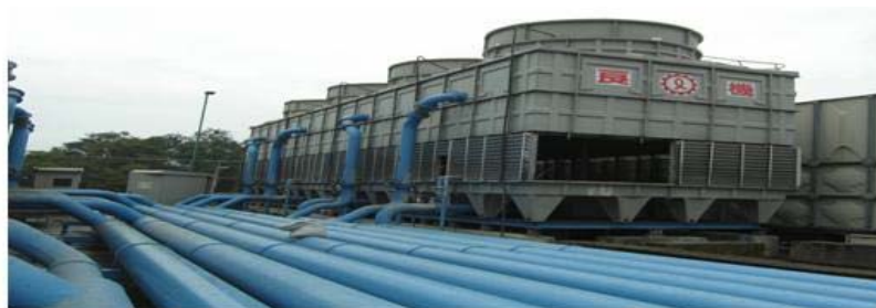
儲冰用冰水主機冷卻水塔現場實景×4台
