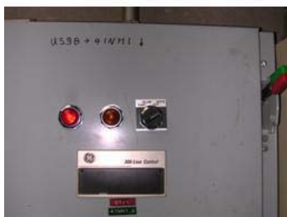
← 冷卻水塔風車 未更換變頻器 前之控制盤
