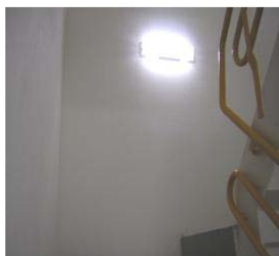
← 安全梯間更換20W日光燈電子式安定器燈具
