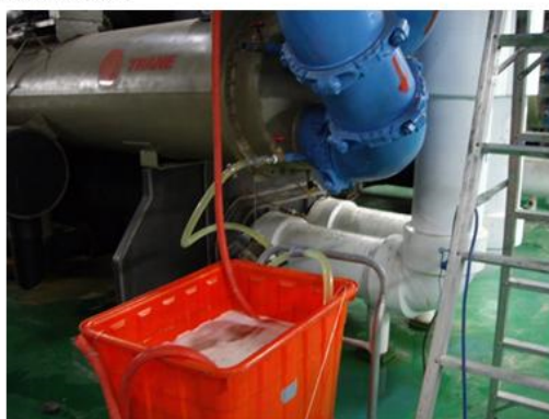
(2)利用小型循環泵使藥水在系統內循環清洗
