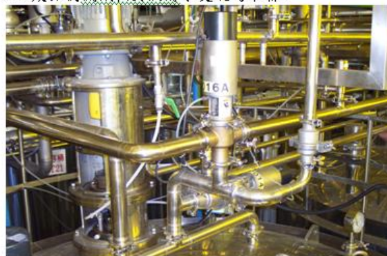
CT 成品桶機械軸對潤滑水更改為串聯
