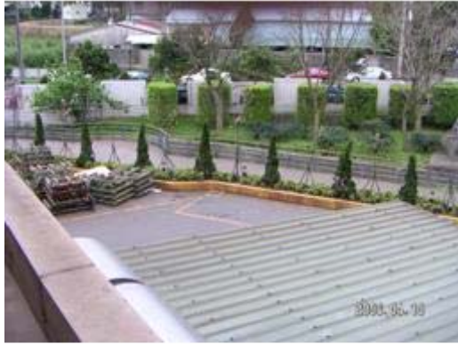
沖壓場空壓機排風口
