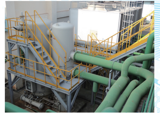
電能節能改善 - 採用墨田式乾燥機取代冷凍式乾燥機
