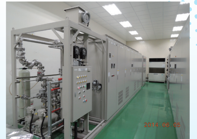
電能節能改善 - 採用馬達變頻驅動系統
