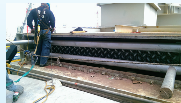
加熱爐新增爐管 (節熱器)
