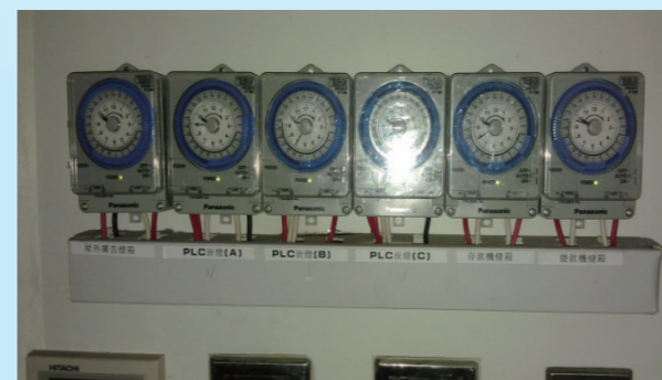
用電設備採時間控制
