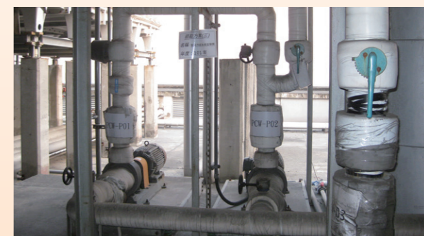
製程冷卻水系統管路連通整併共用
