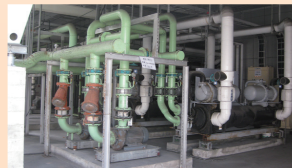
冷卻水管路並聯改善
