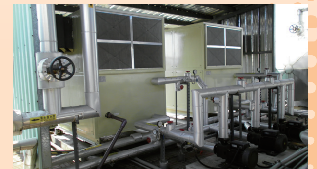
學生宿舍裝熱泵熱水系統
