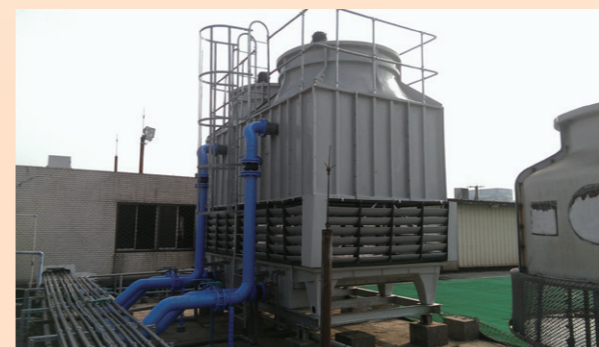
中正館冷卻水塔汰換
