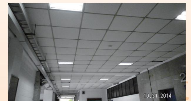
傳統 T8 燈具逐年更換為 T5 燈具及 LED 燈
