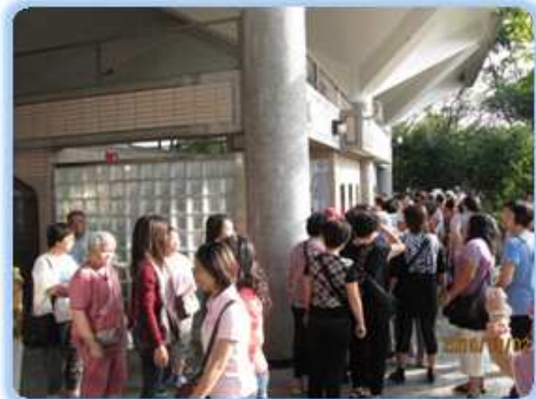
未增建廁所前女性用路人於女廁前大排長龍等候上廁所的擁擠狀況
