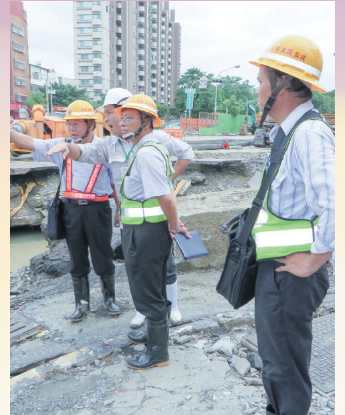
▲高雄氣爆赴現場勘查電纜受損狀況。(右2)
