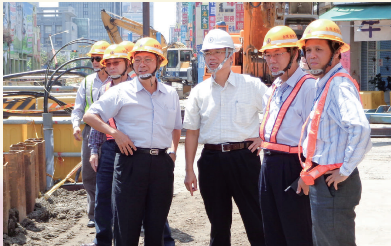
▲高雄氣爆赴現場勘查電纜受損狀況。(右4)
