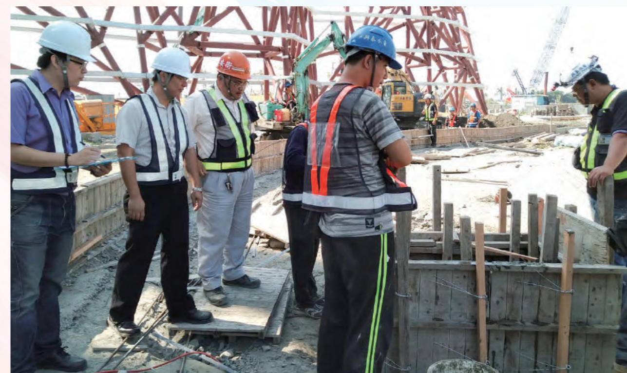
▲ 團隊成員於海洋文化及流行音樂中心工地視察。
