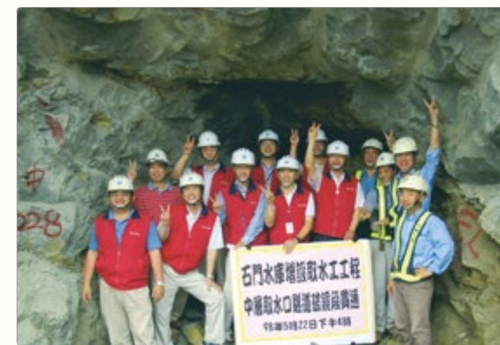
▲ 分層取水工中層取水口隧道貫通。(前排左五)
