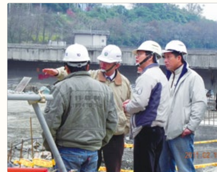
▲ 督導石門水庫電廠防淤一期工程施工。(左二)
