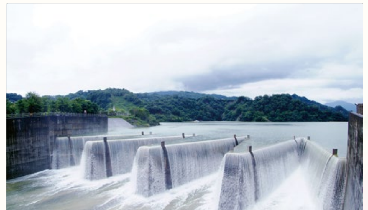
▲ 鯉魚潭水庫鋸齒型溢洪道溢流實況。
